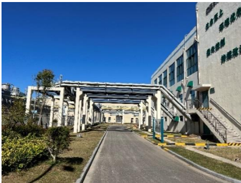
变电站进出线
